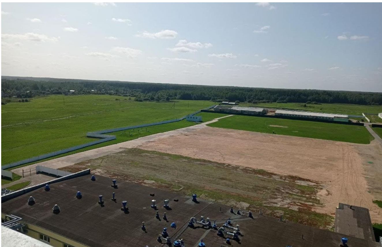
Рисунок 4.9 — Вид с крыши главного производственного корпуса на запад, территория для реализации планируемых намерений
