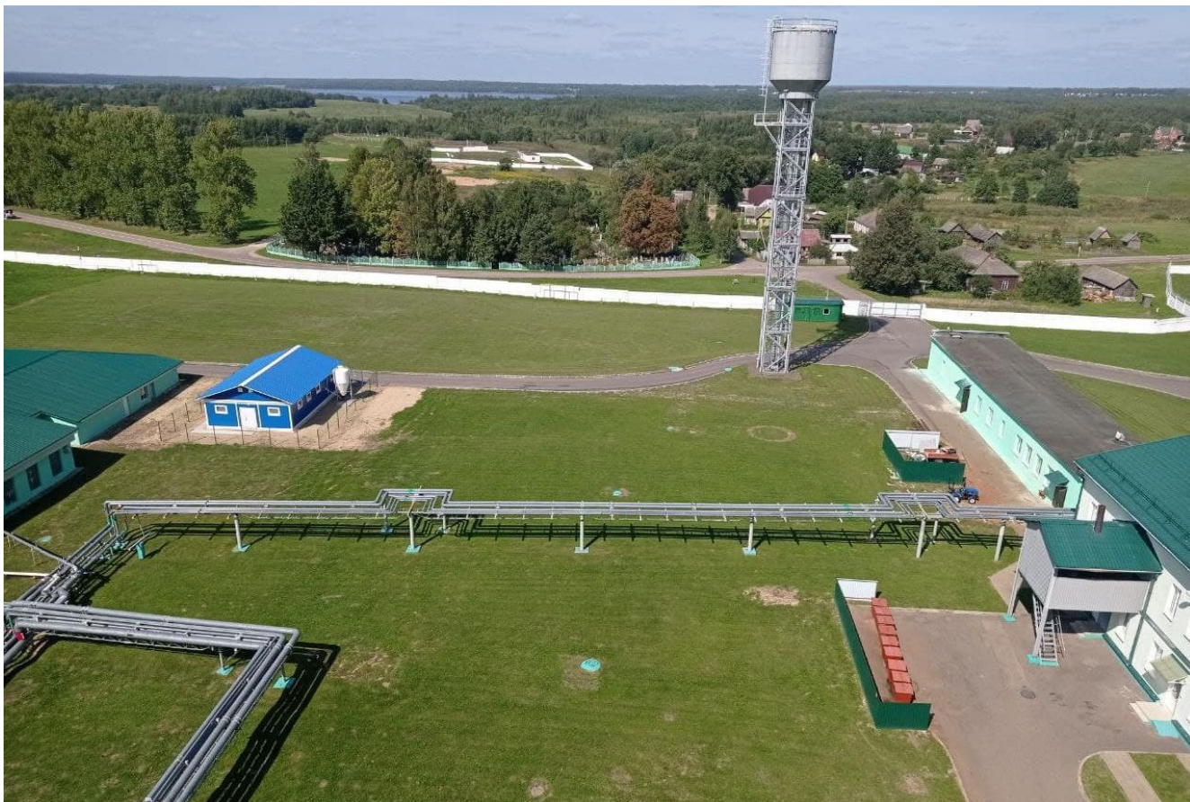
Рисунок 4.8 — Вид с крыши главного производственного корпуса на север
